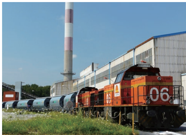
ブツワ工場内の鉄道
