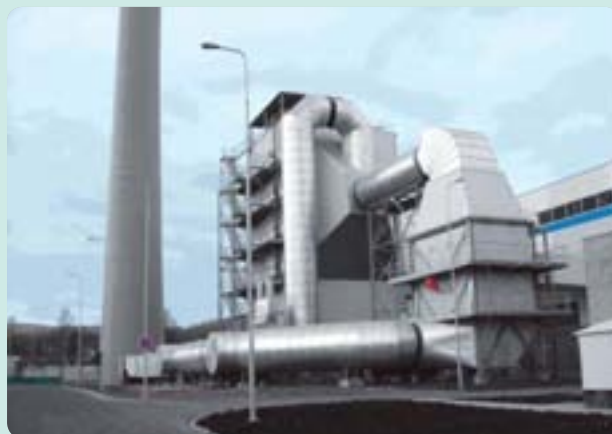
チェコ(Retenice工場)の大気汚染防止装置
