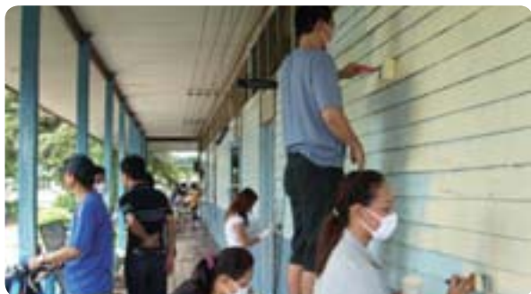
手分けしてペンキを塗る、壁の修繕作業
