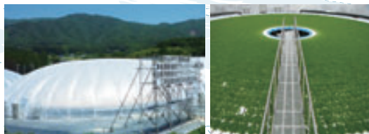
高機能フッ素樹脂フィルムを採用した陸前高田市のエアドーム式植物工場
