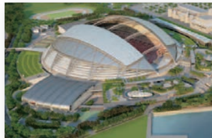
アフレックスを屋根に使用した ナショナルスタジアム
