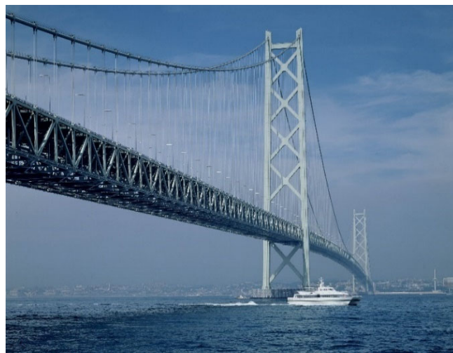
明石海峡大橋
