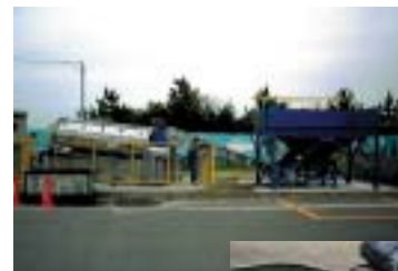
カレット洗浄設備
