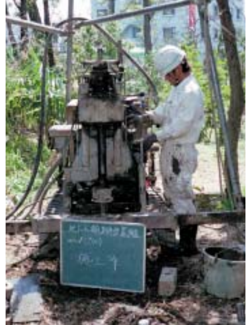
土壌ボーリング調査
