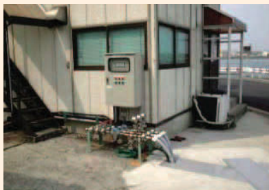
上: 遮水壁や揚水施設を設置した範囲。帯水層とは砂層など水を通しやすい地層。通常、地下水はここに存在する。難透水層は粘土層など水を通しにくい地層 左: 汚染水の揚水施設。くみ上げられた地下水は水蒸気蒸留によって浄化される
