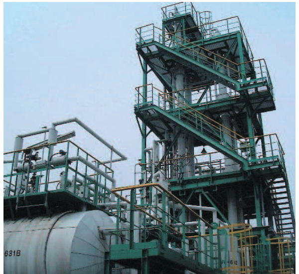
2001年度に稼働を開始した、フロン22(HCFC-22)の回収・リサイクル設備。フロンは生産規制だけでなく、既存製品回収後の排出抑制も重要視されつつある。当社では「守る地球、オゾン層」の理念のもと、家電リサイクル法に基づき、家庭用エアコンから回収したフロン22を精製して、フッ素樹脂の原料として再利用している
