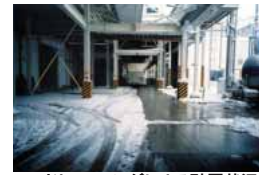
ロードヒーティングによる融雪状況
