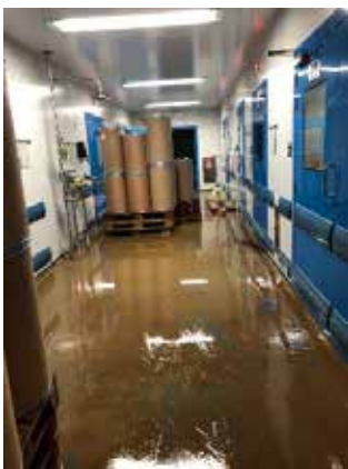
浸水被害を受けたAGCファーマケミカルズヨーロッパのフロア
