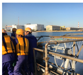
海上オイルフェンス展張訓練(千葉工場)
