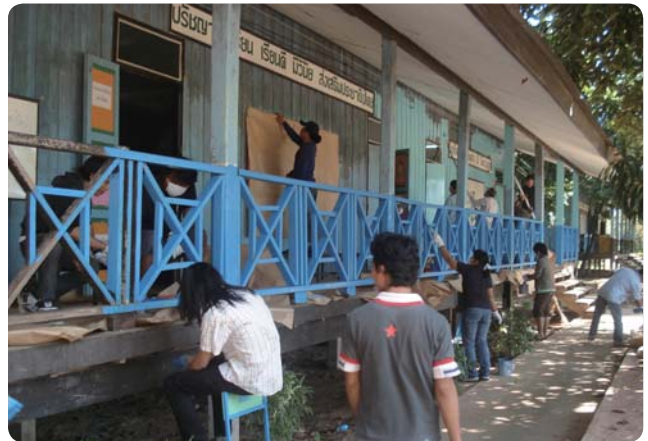
従業員による校舎の修繕
