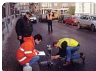
道路検査技師による反射道路の性能検査(ベルギー)
