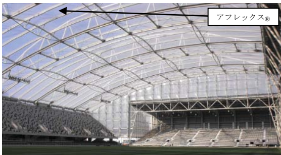
【スタジアム内部（屋根部分にアフレックス®を使用）】
