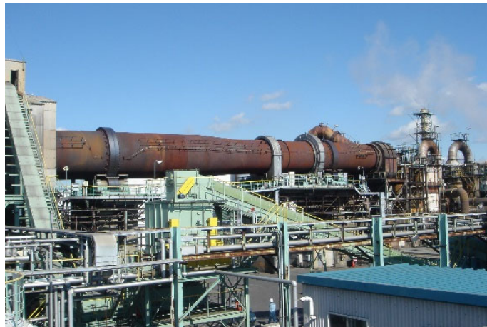
JX金属苫小牧ケミカル(株)燃焼設備
