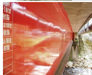
ルミフロン® を 塗布した橋脚 (21年目)
