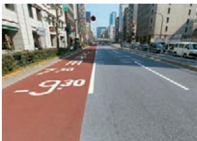
ヒートアイランド現象の解消に寄与する遮熱舗装用セラミックス材料「タフクーレ®」
