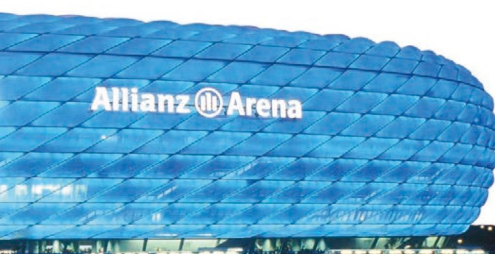
フッ素樹脂フィルム「アフレックス®」が採用されたドイツのサッカースタジアム「アリアンツ・アリーナ」
