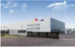
AGC Display Glass (Kunshan), new plant
