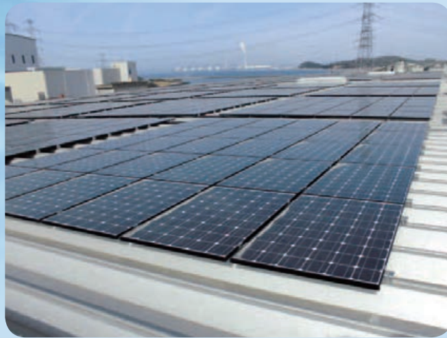
関西工場高砂事業所で稼働を開始した超軽量ソーラーパネル
