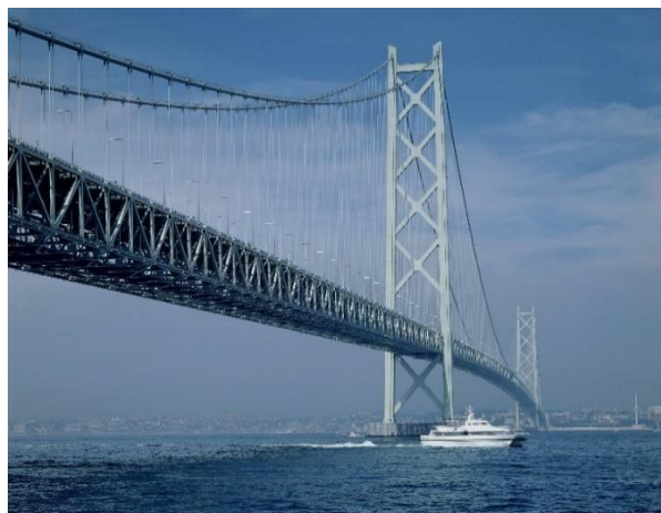
明石海峡大橋
