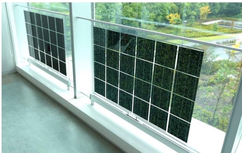
後付けサンジュール 施工イメージ
