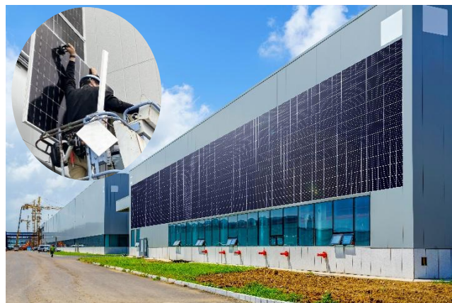
データセンターへの施工イメージ
