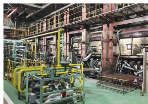
実証試験を行うガラス溶解炉
